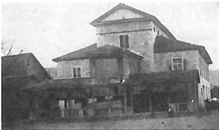
Das alte Schützenhaus (Vorgängerbau des heutigen «Casinos») um 1880. Im Vorbau der Schiessstand von 1837. Scheibenstand im Gebiet der heutigen Badeanlage («Schützenmatte»). Foto von Joseph Lüthy, Bremgarten
