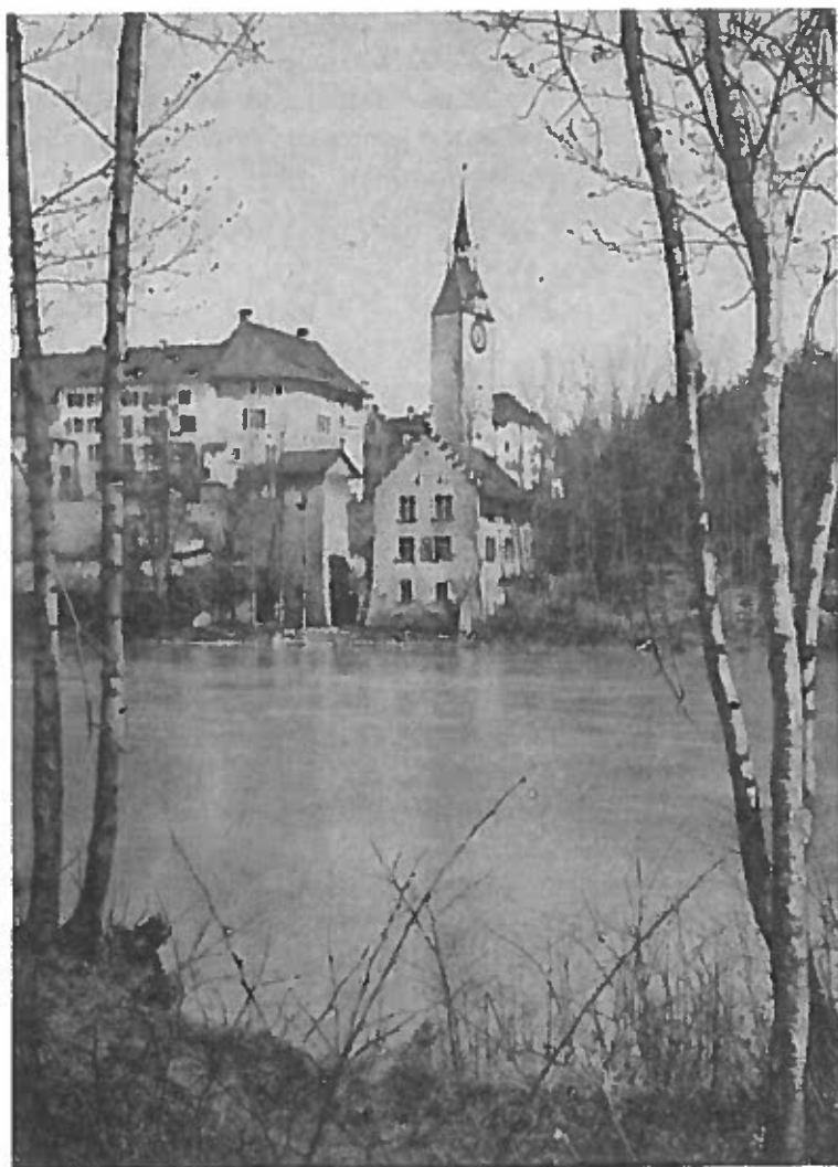
Das älteste Schützenhaus (heute: Café «Bijou»), vor der Renovation, um 1905. Bis 1836 schoss man von hier aus reussaufwärts.
